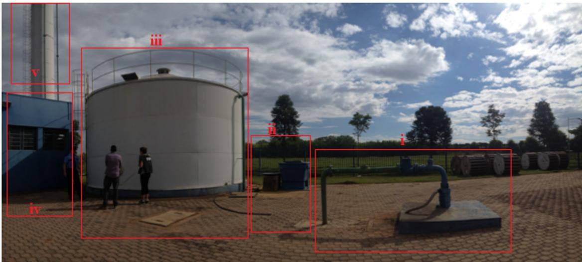
Figura 4 - **Captação e reservação da água do campus 2**
