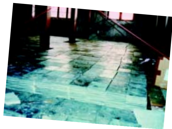
Aspecto de uma das câmaras da CBJ, vendo-se o piso de chumbo usinado e parte da estrutura de apoio
