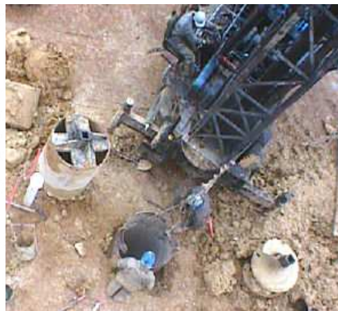
Esquema do revestimento de poços.
