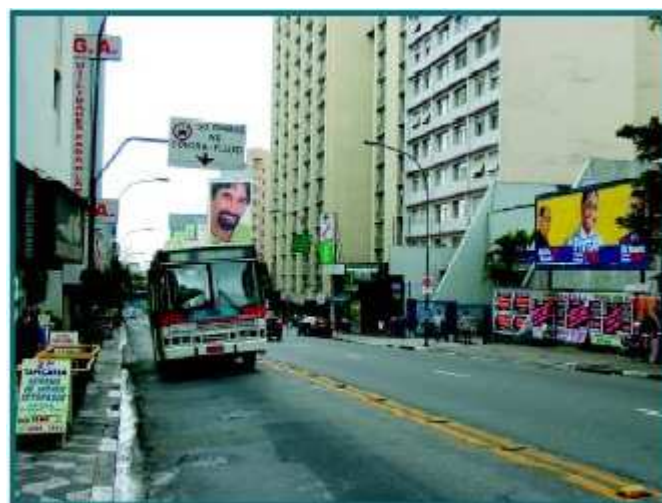
Figura 2 – Faixa exclusiva sem segregação física, com tachão, no sentido do contra-fluxo de tráfego.
