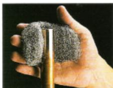
Use palhinha de aço ou mesmo uma escova de fio para limpar a bolsa da conexão e a ponta do tubo.
