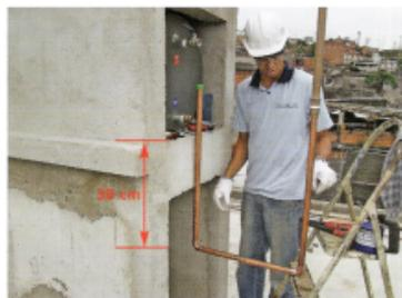
A alimentação de água fria do reservatório deve conter no mínimo 150 cm de tubulação anterior ao sifão. É recomendável que o material dessa tubulação seja em cobre ou material que suporte a alta temperatura do sistema.
