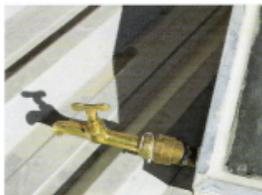
Deve-se instalar um sistema de dreno (registro de gaveta, esfera, torneira, etc) na parte inferior da bateria dos coletores solares.
