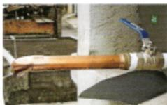
As entradas e saídas de água no reservatório térmico devem possuir registros de esfera ou gaveta e uniões para eventuais manutenções e reparos na instalação, excetuando-se em saídas para os dispositivos de segurança.
