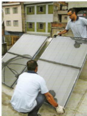
É cada vez mais comum a instalação de sistemas de aquecimento solar em edifícios para suprir a demanda de água quente de todos os apartamentos. A instalação dos coletores solares pode ser realizada utilizando-se suportes metálicos ou sobre planos inclinados já previamente definidos no projeto arquitetônico.
