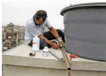
O reservatório térmico não deve ser alimentado pela "água da rua", devido a variações constantes de pressão ao longo do dia.
