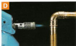
Aplique a chama sobre a conexão para aquecer o tubo e a bolsa da conexão até atingir a temperatura de soldagem.
